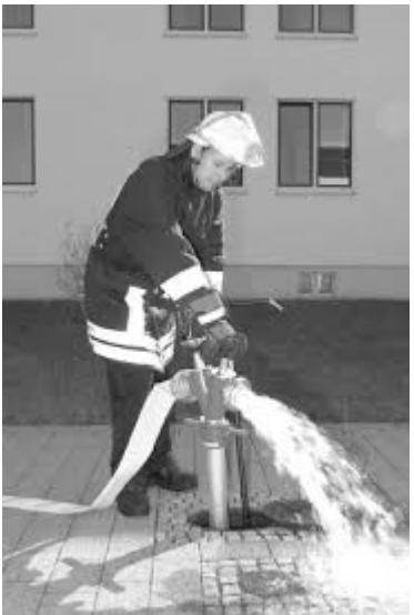
Bei einer Wasserentnahme aus Schachthydranten muss dieser zur Reinigung gründlich gespült werden, bevor das Standrohr aufgesetzt wird!!!
